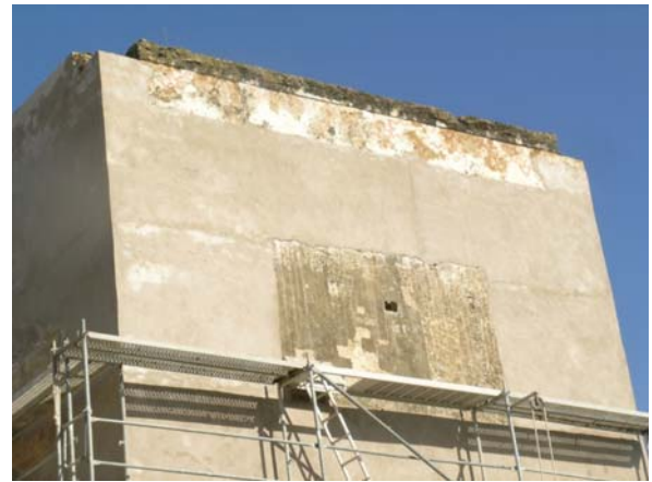
Fig. 3. Detalle de la ubicación y estado de conservación del reloj vertical declinante. Bajo la cornisa, se puede observar restos de la decoración de pintura mural al fresco. Detail showing the position and condition of the declining vertical sundial, as well as the remains of a fresco under the cornice.
